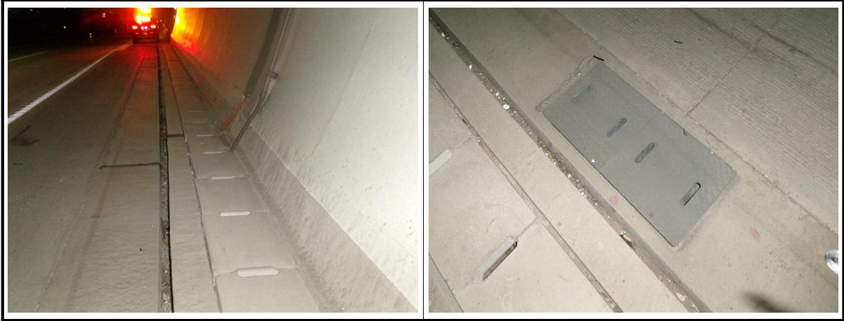
【사진 4.3.8】 공동구 및 배수시설 전경
