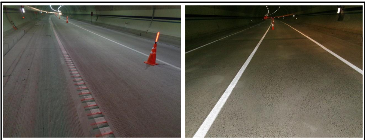
【사진 4.3.10】 포장부 전경
