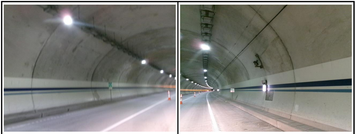
【사진 4.3.16】 라이닝 측벽부 전경
