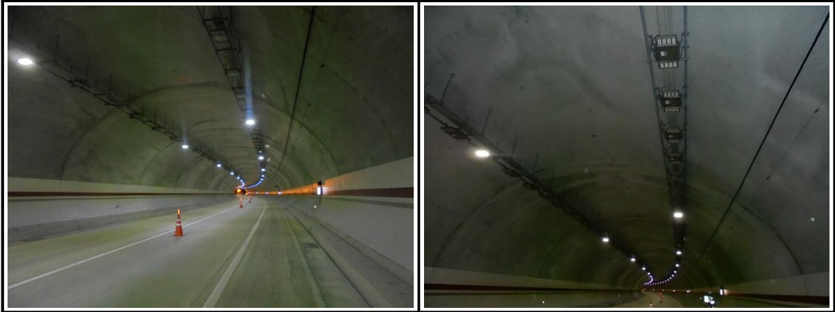
【사진 4.3.14】 라이닝 천단부 전경
