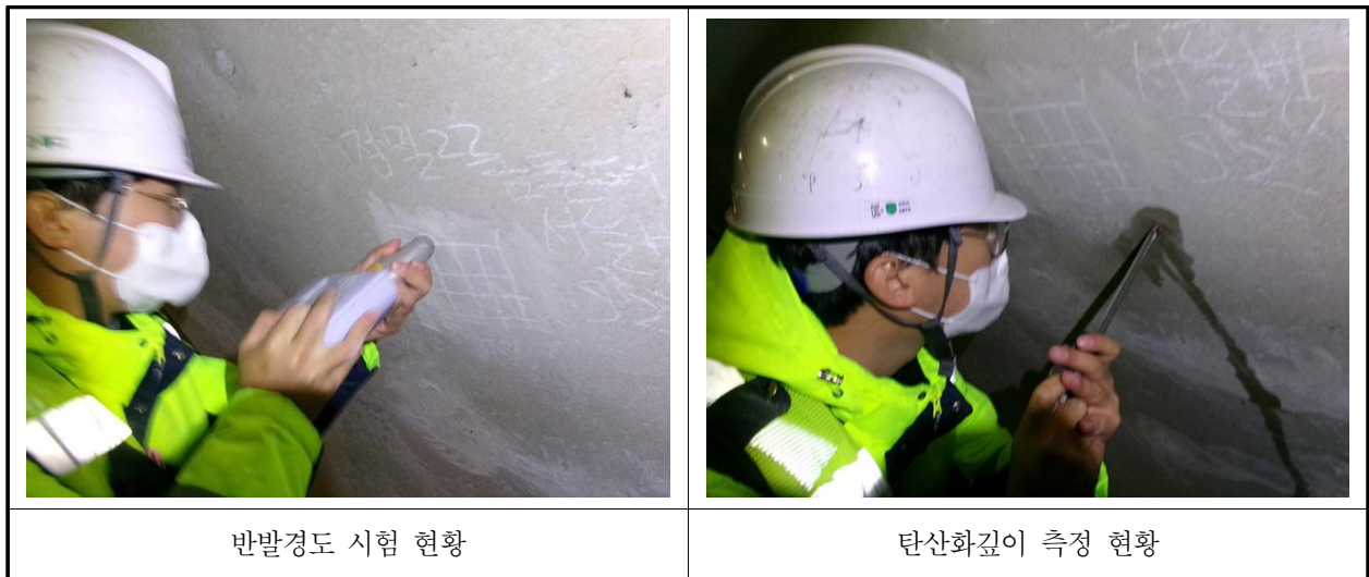
【사진 4.4.1】 콘크리트 내구성조사 현황
